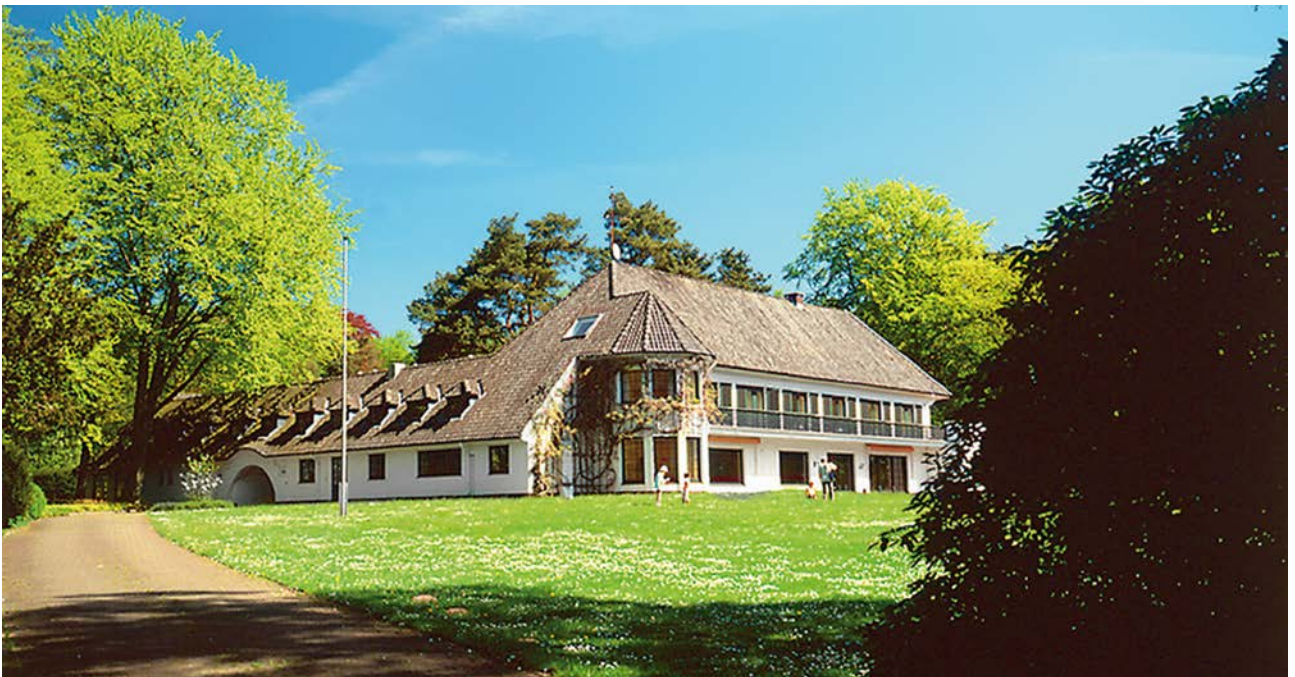
Die Sternenbrücke in Hamburg Rissen
